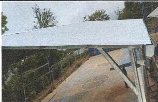
Foto: 2 Mejoramiento de cubierta de techo con lámina troquelada calibre 26 para cancha
