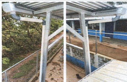
Foto: 6 Instalación de bajada de agua pluvial
