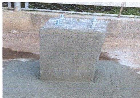
Foto: 4 Instalación de pedestales de concreto para soporte de estructura en cancha
