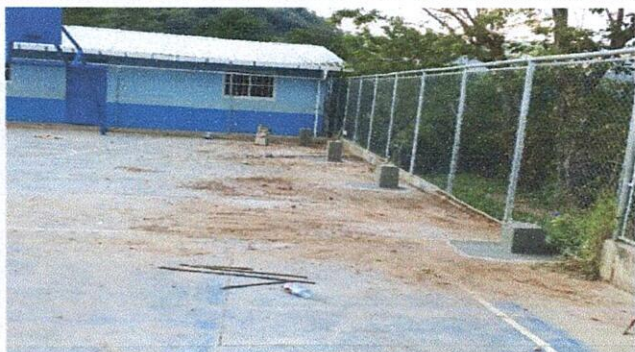
Foto: 3 Instalación de zapatas para pedestales
