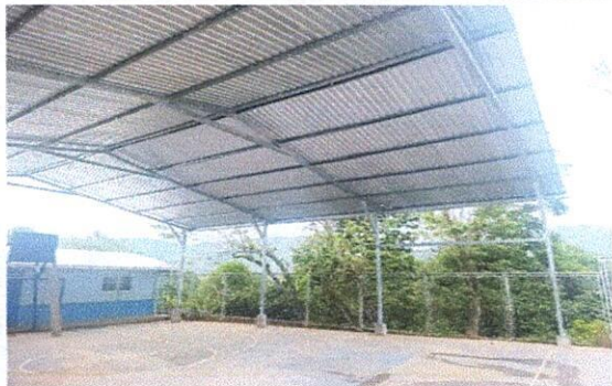
Foto: 1 Mejoramiento de estructura metálica tipo pórtico para cancha finalizado
